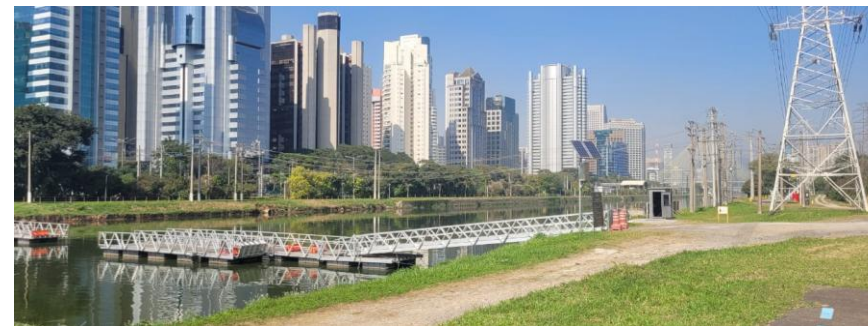
CICLOPASSARELA Conexão entre as margens do rio
