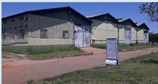
Galpões (9A-9D) Área Construída total de 2.165 m 2
