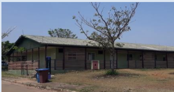
Galpões (Prédio 9E) Área Construída: 722 m 2
