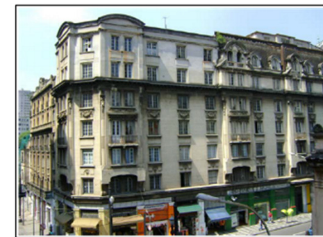
F.1 - Vista a partir de um edifício vizinho - esquina das ruas Roberto Simonsen com Wenceslau Brás.
