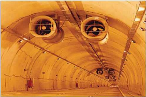
Longitudinal ventilation
