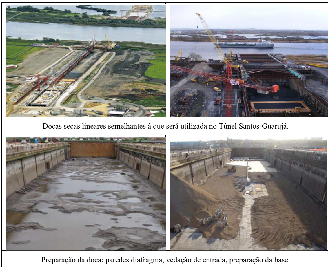
Figura 6.3.1.1-3 - Instalação e operações em uma doca seca para produção dos módulos
