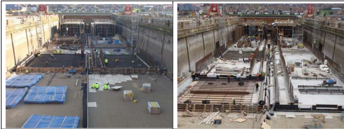
Construção dos módulos de concreto.
