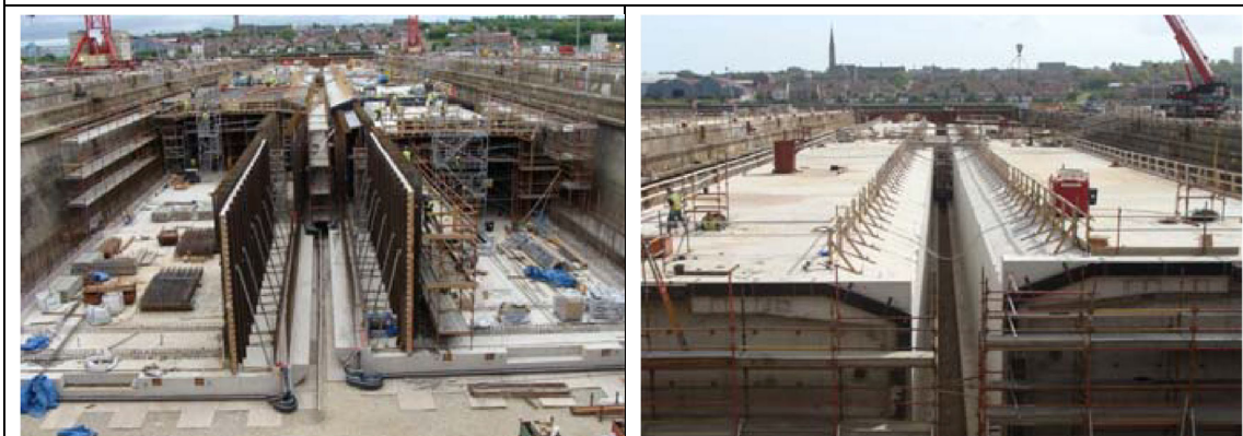
Construção dos módulos de concreto.
