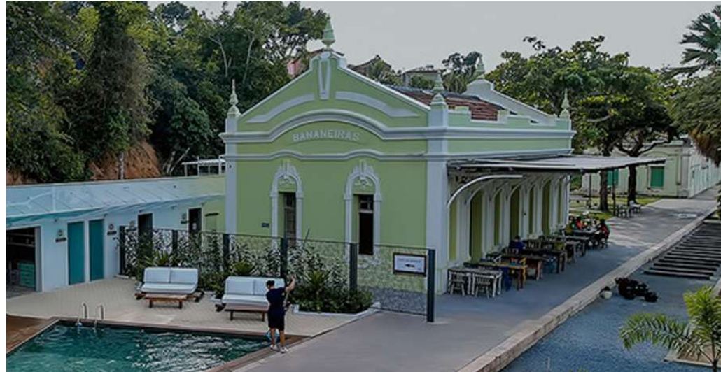
Fonte: Pousada Estação Bananeiras, Bananeiras, Paraíba, 2023
