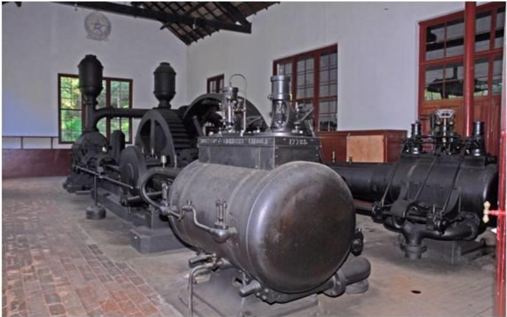
Casa da Bomba
