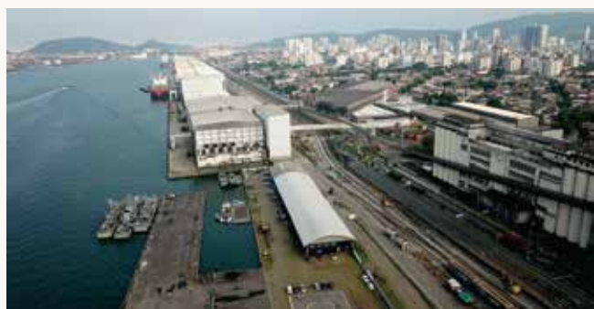
Instalações do Porto de Santos.
