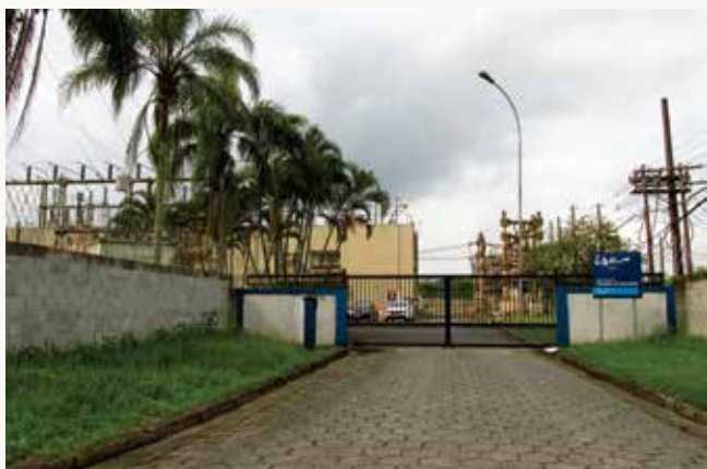
Subestação Vicente de Carvalho (Uso Institucional e Equipamento Urbano).
