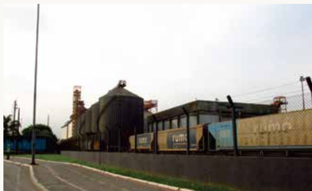
Instalações do Porto de Santo às margens da Avenida Perimetral.
