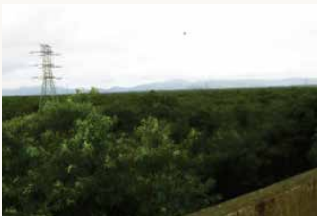
Vista da área em que será implantado o futuro acesso à SPA-248/055.
