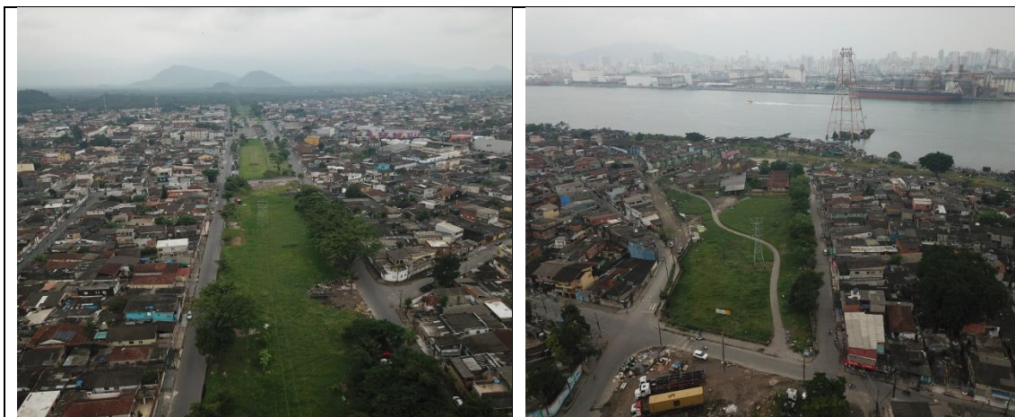
Fotos 51 e 52: Vista geral de campo antrópico na faixa de servidão de LT, no bairro Vicente de Carvalho, Guarujá, trecho de implantação do Túnel Imerso Santos - Guarujá. Notar árvores isoladas e/ou em agrupamentos. (Coord. UTM 23K 367489 7350820)
