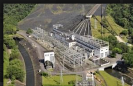
UHE Henry Borden Pot. Inst.: 889,0 MW Gar. Física: 115,4 MW
